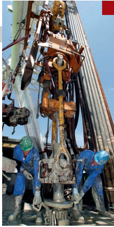
Bohrturm des Geothermie-Kraftwerks in Unterhaching
